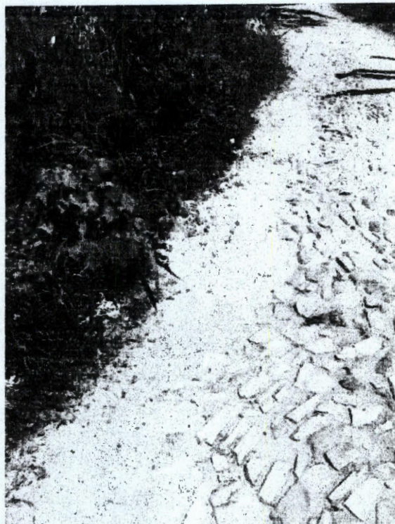
Figura 16-Recomposição de pedra tosca e regularização de base.
