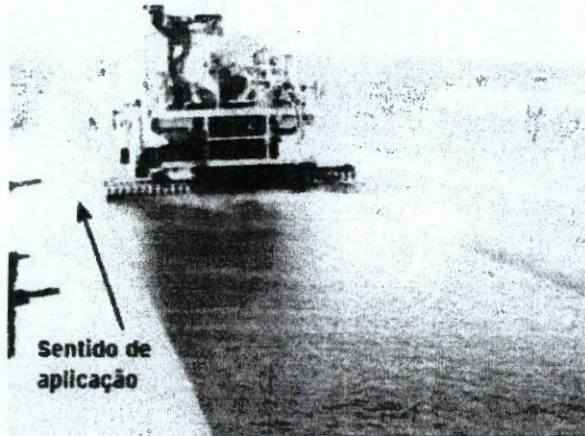
Figura 5 - Aplicação do ligante (esq) e Distribuição de agregados (dir). (BERNUCCI, et al, 2006)
