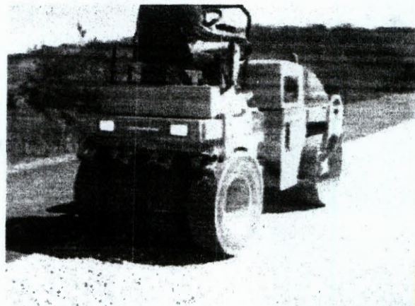
Figura 6 - Correções de imperfeições (esq) e Compressão dos agregados (dir). (BERNUCCI, et al, 2006)
